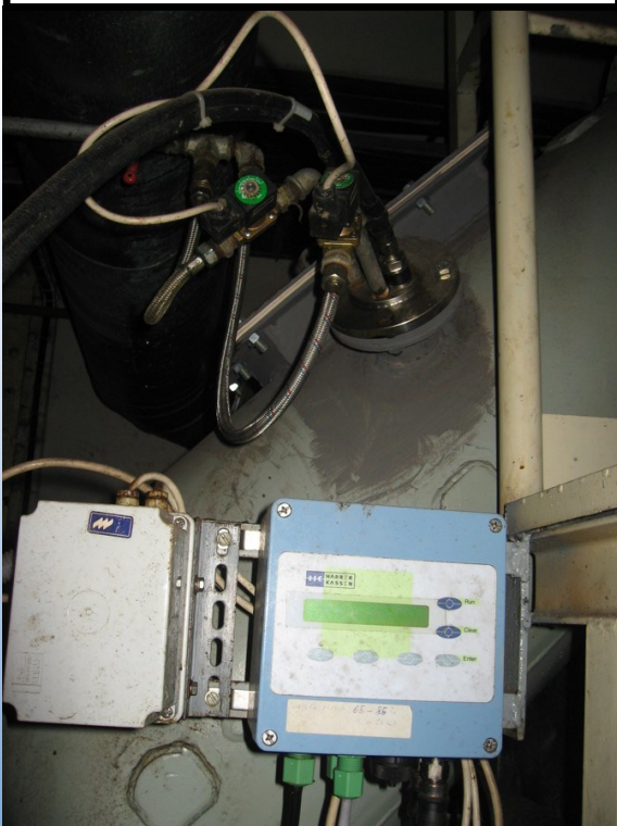
HK2 Stabsensor mit Spülfunktion Sugar
