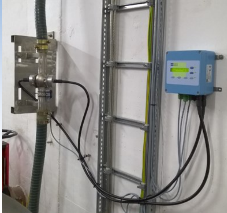
HK2 Spiralantennen mit PT100 Klärschlamm
